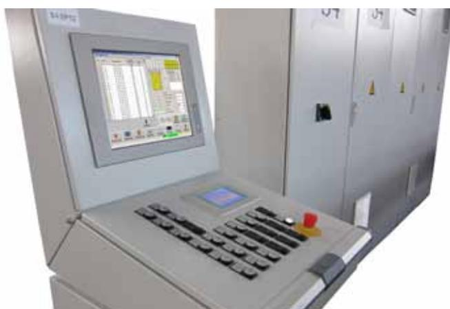
Schaltschrank mit Bedienpult
